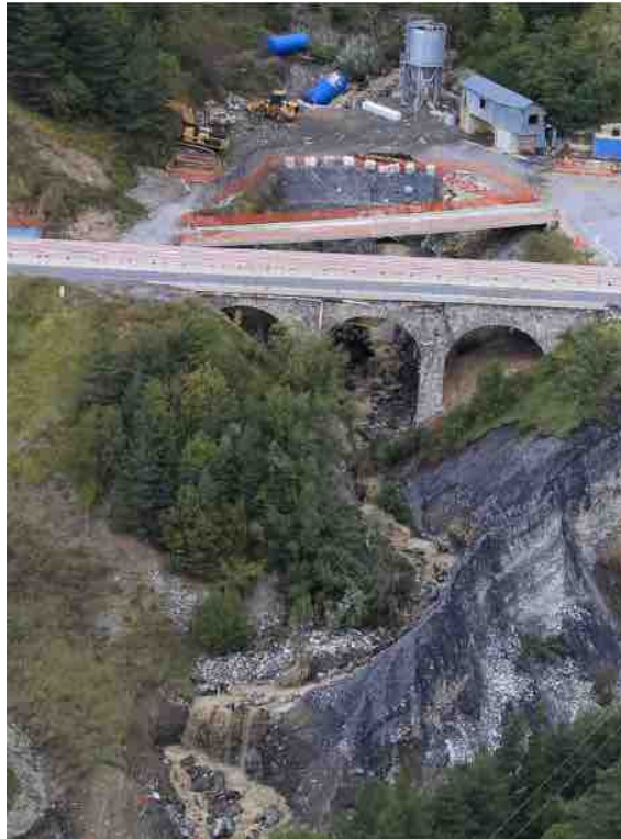
Figure 48 Passage intubé sur le ruisseau de La Cà Entre les deux viaducs, on voit le tuyau qui laisse passer le ruisseau Cà. Le flux sortant (visible au niveau de la petite cascade en aval du viaduc en maçonnerie n'est pas très important).
