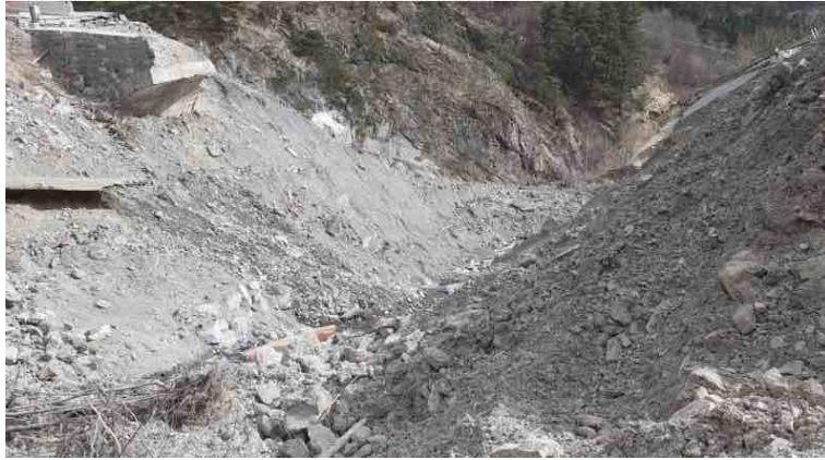
Figure 40 Zone de dépôt au niveau du viaduc
