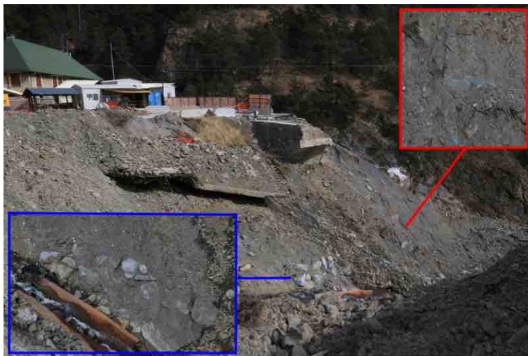
Figure 43 Murs en aval des viaducs
