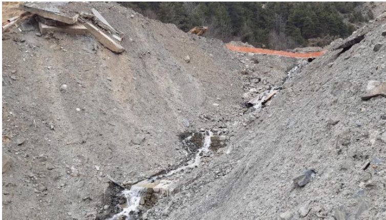
Figure 42 Seuils dans le lit inférieur de La Cà
